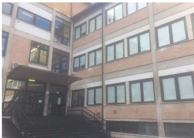
Già partiti i lavori All'Istituto di istruzione superiore tecnico "G. Spagna"
